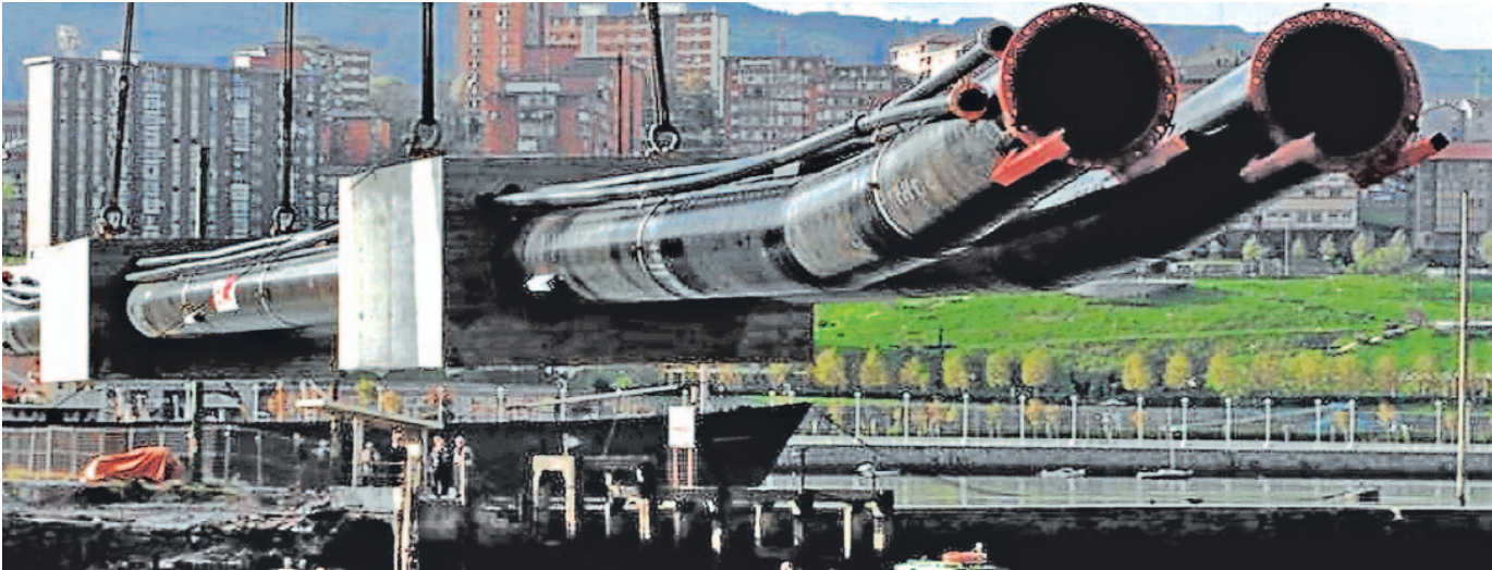
Imagen de archivo de la inmersión en la Ría del colector submarino que lleva los vertidos de la Margen Derecha desde Lamiako hasta la depuradora de Galindo. EL CORREO
